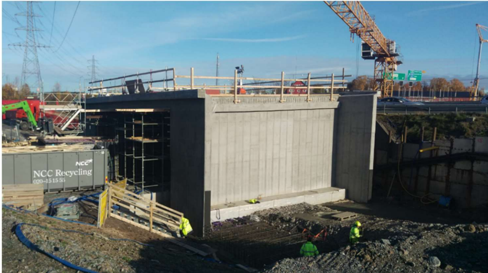
Bild 2: Pågående byggarbete med betongbron i projektet Häggviks Trafikplats.
