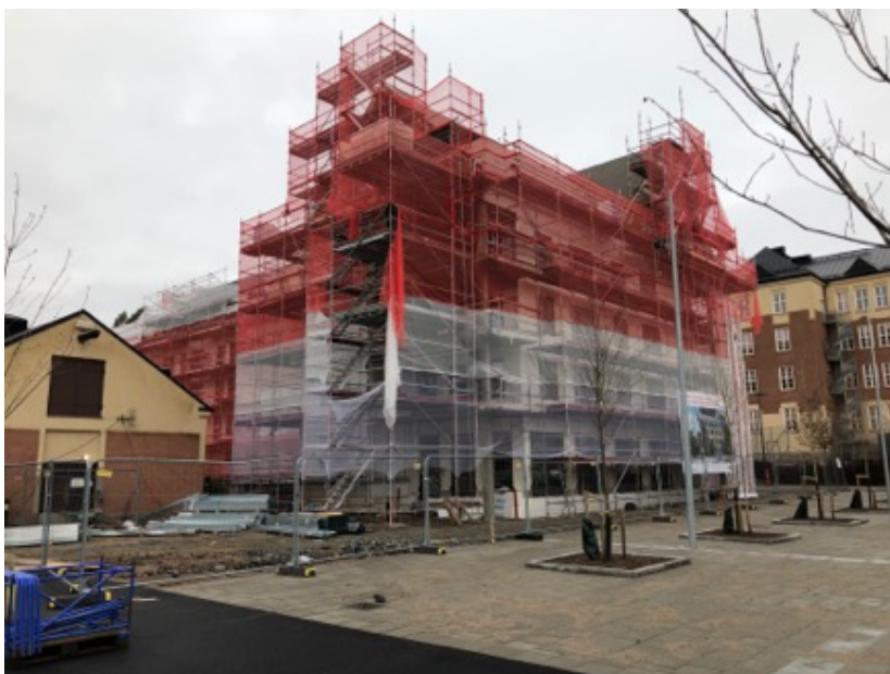
Bild: Byggarbetsplatsen Majoren, Borås, november 2019
